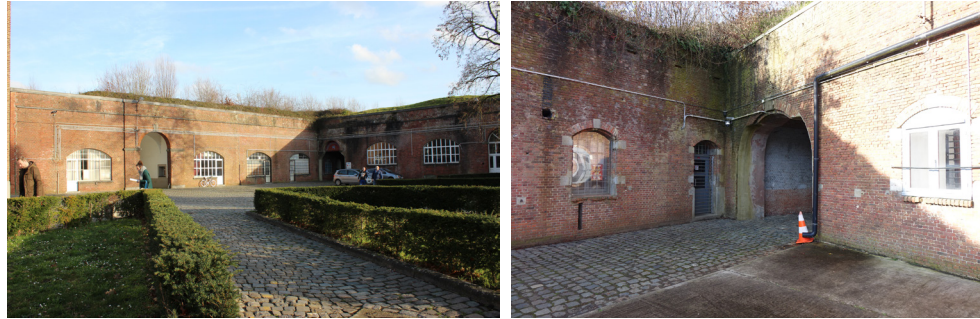
afb. 228: Gevels courtine 1-2 (pegasus-museum) - Afvoerpijpen en witte elektrische bekabelingen in opbouw verstoren de gevels. 2018. © ORIGIN
