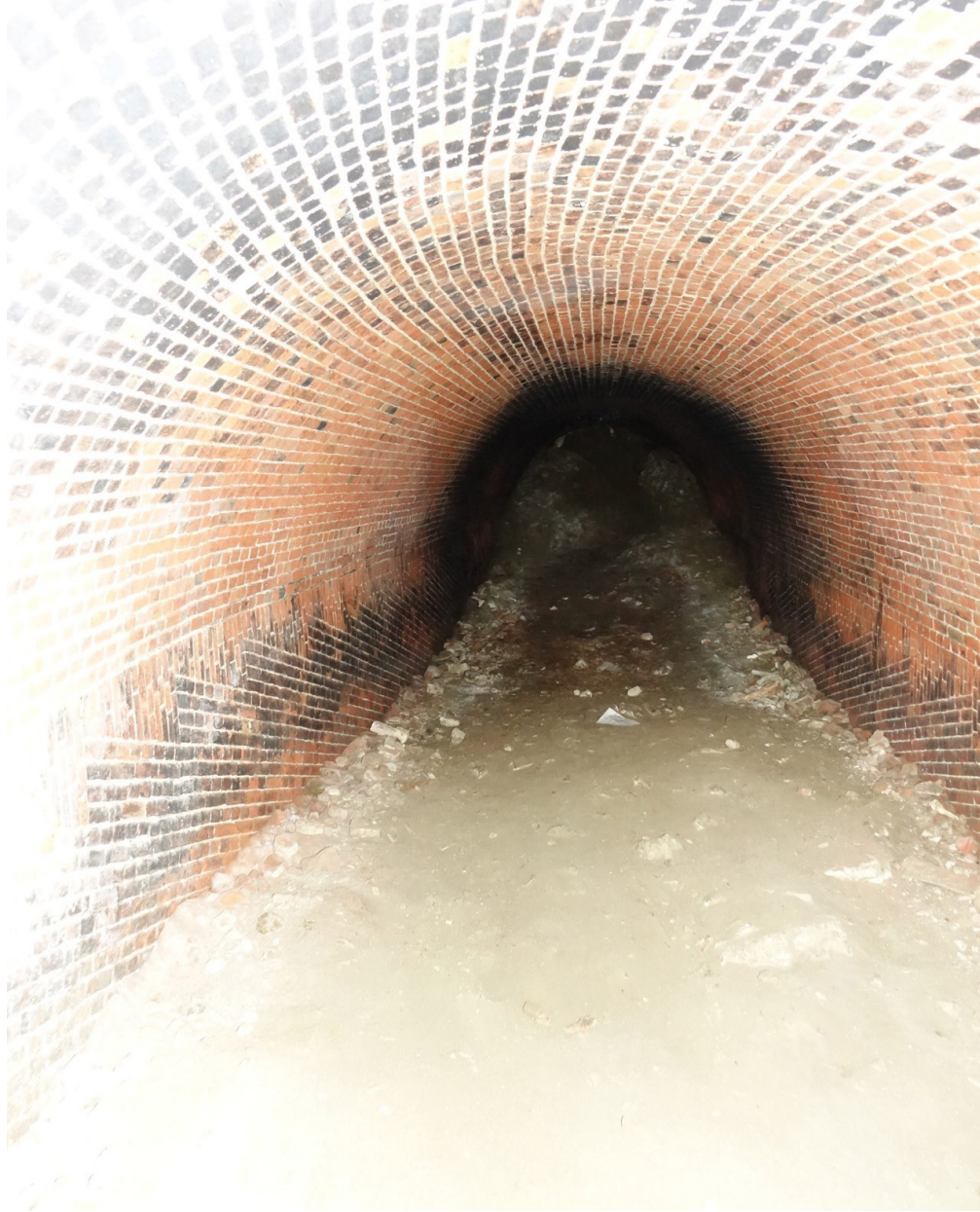
afb. 79: toegemaakte gang in artillerietoren naar afgebroken bastion 1 © Origin
