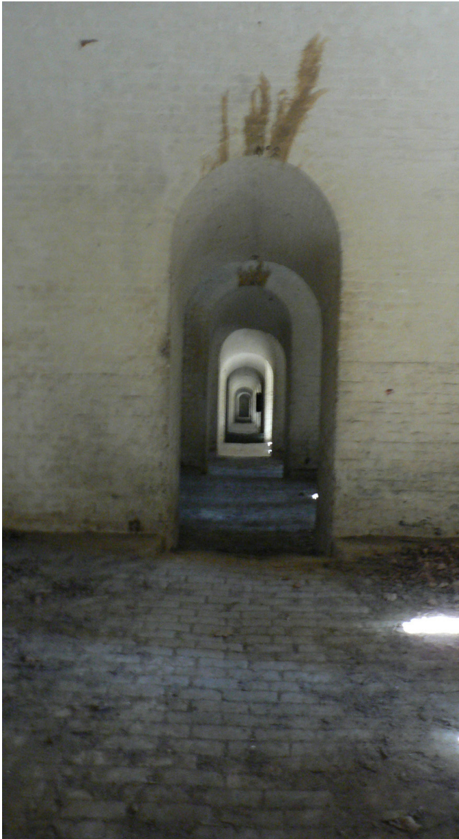
afb. 93: Kazematten gecreneleerde escarpmuur. Bron: Citadel te Diest: Bouwhistorisch onderzoek, p. 62
