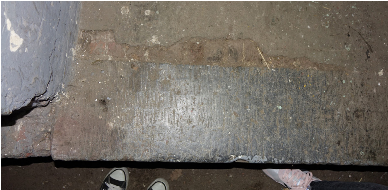
afb. 127: Arduin toegepast als dorpel in het interieur © Origin
