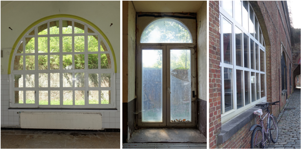
afb. 212: Recente schrijnwerken (in PVC, Staal en tropisch hardhout) in vergrootte gevelopeningen courties. 2018. © ORIGIN
