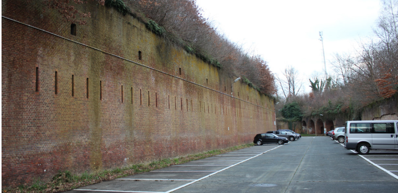
afb. 33: Gebetonneerde parking voor courtine 2-3. 2018 © Origin
