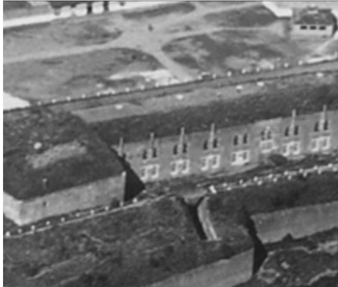
afb. 19: Ramen courtines grachtzijde - Rondboogvensters onderste verdieping.1924-1926. © BRANS Marc. Bron: MOP, Citadel te Diest: Bouwhistorisch onderzoek. p. 86
