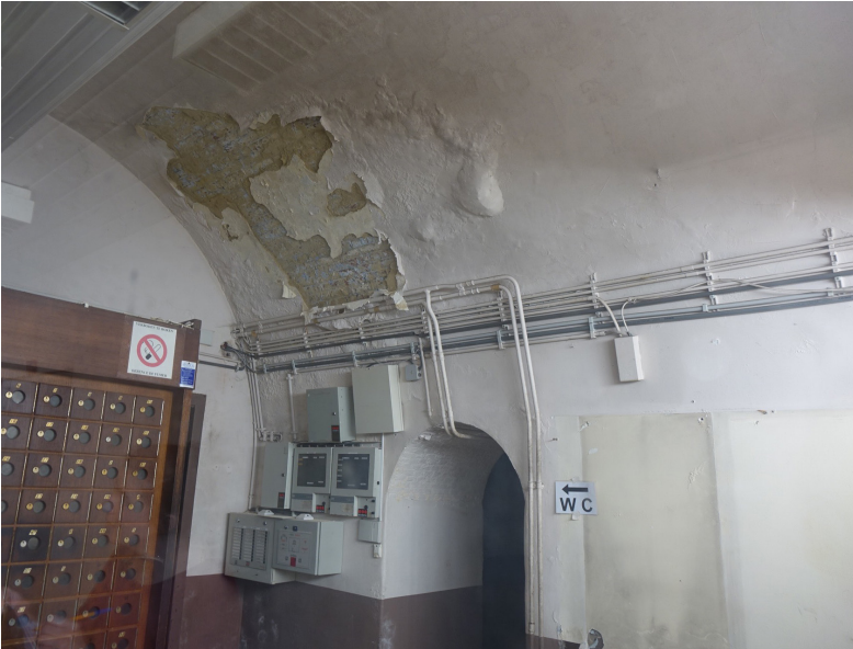
afb. 172: Afbladderende verf interieur courtine 1-2 © Origin
