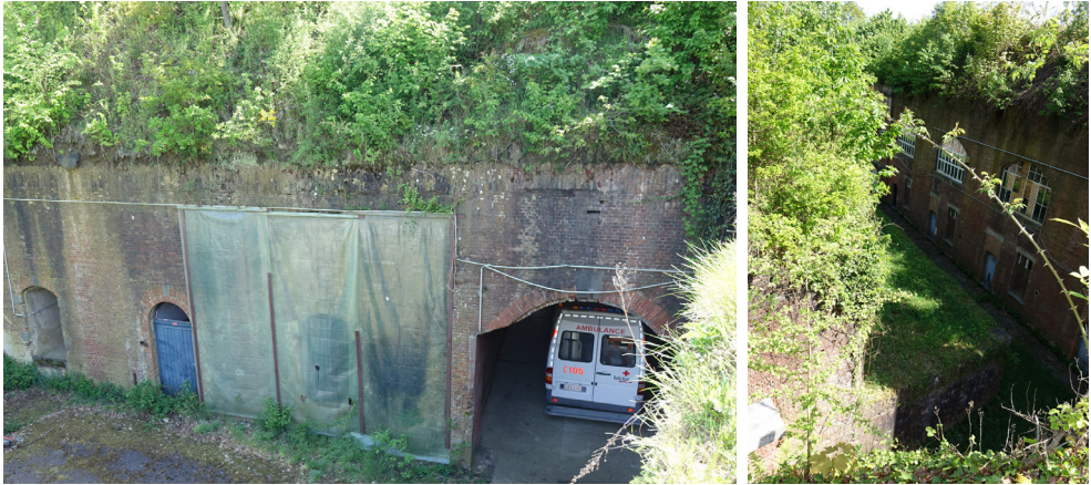
afb. 223: Dakranden uit hardstenen goten - de goten vrijwaren van vegetatie is essentieel voor het vermijden van waterschade in het interieur. 2018. © ORIGIN
