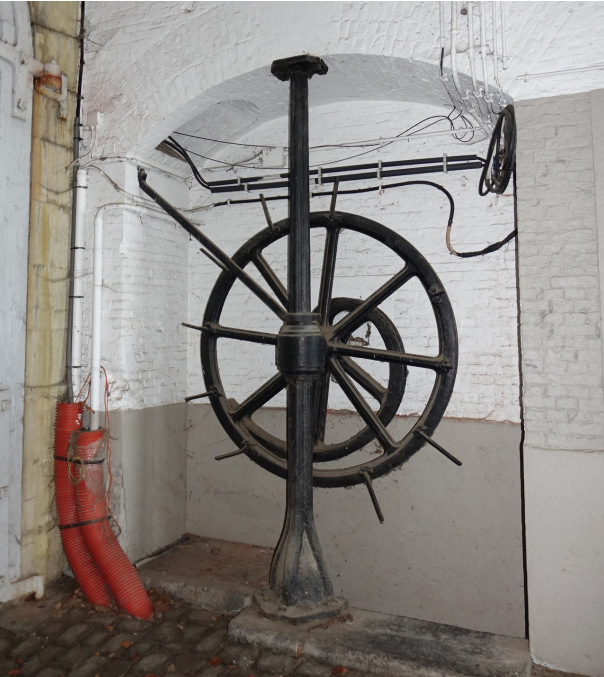
afb. 149: Gietijzeren ophaalmechanisem van de vroegere ophaalbrug in poterne van stadspoort ©Origin
