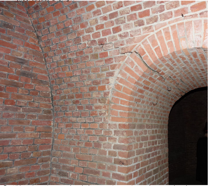
afb. 179: Barst in metselwerk deuopening gesitueerd gecreneleerde galerij bastion 4 © Origin
