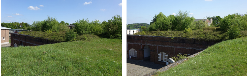
afb. 223: Dakranden uit hardstenen goten - de goten vrijwaren van vegetatie is essentieel voor het vermijden van waterschade in het interieur. 2018. © ORIGIN
