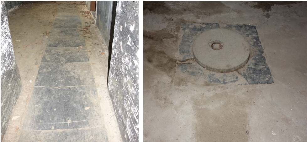
afb. 226: Deksel van een cistern en een aquaduct in hardsteen met bakstenen vloer - kelderverdieping, 2018. © ORIGIN
