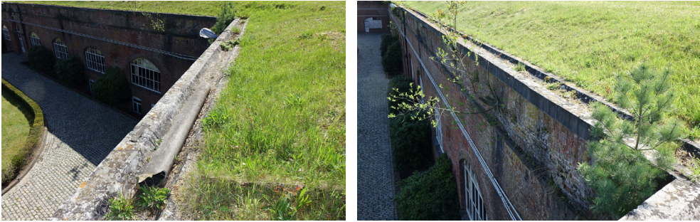
afb. 223: Dakranden uit hardstenen goten - de goten vrijwaren van vegetatie is essentieel voor het vermijden van waterschade in het interieur. 2018. © ORIGIN
