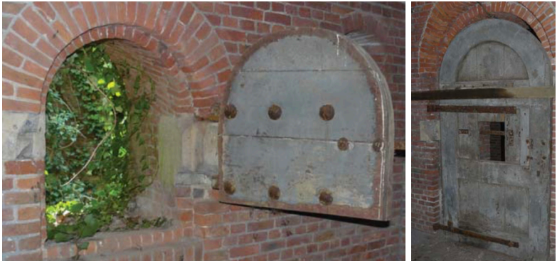
afb. 213: Schietluik en deur van Chasseloup de Labaut systeem - periode citadel als citadel (06/09/'13) © JANNES, Daniel. Bron: MOP, Citadel te Diest: Bouwhistorisch onderzoek
