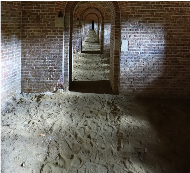
afb. 144: Aangestapte aarde in de gecreneleerde galerij van een tenaille ©Origin
