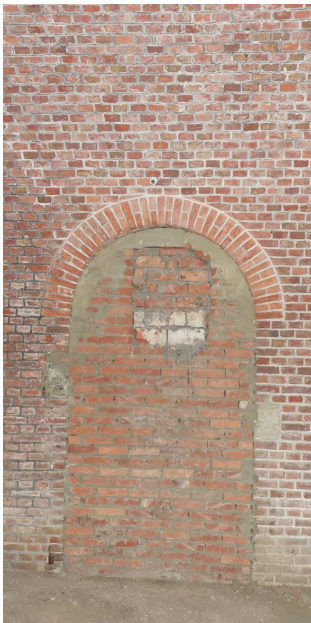
afb. 206: Schietgaten en deuropeningen van de defensieve galerije toe gemaakt met metselwerk. 2018. © ORIGIN
