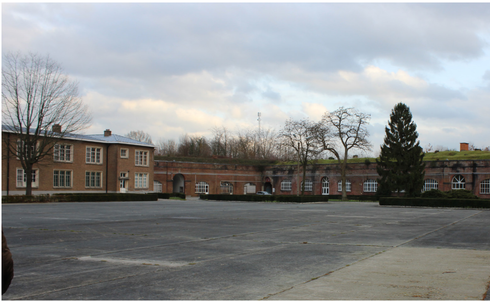
afb. 50: Huidige situatie, gebetonneerd plein. 2018. © Origin
