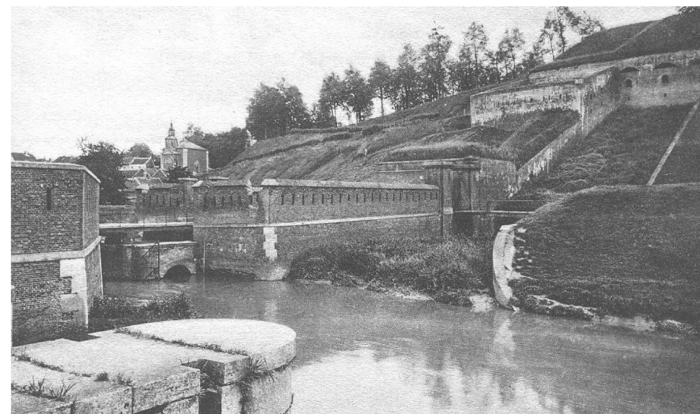
afb. 73: Zichemse poort met erachter het wachtlokaal en bovenaan de gekazemateerde artillerietoren. Bron: Citadel van Diest: militair bouwwerk doorgelicht: verleden-heden-toekomst. p. 68
