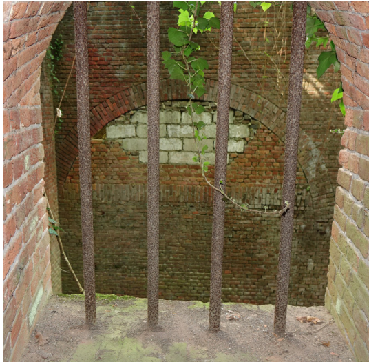
afb. 207: Met metselwerk toe gemaakt chasseloup-laubat systeem. 2018. © ORIGIN
