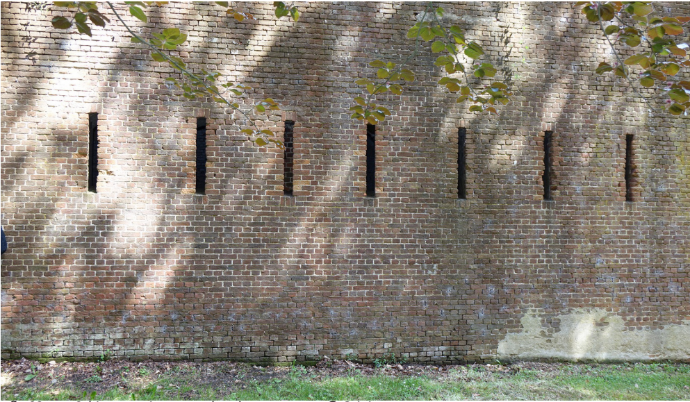
afb. 92: Schietgaten in gecreneleerde escarpmuur © Origin
