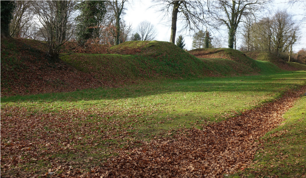
afb. 91: Overblijfselen van aarden contrescarp © Origin
