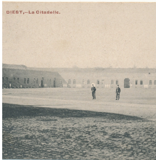
afb. 45: Terreplein met kasseien en zand. 1918 © Delcampe bron: www.delcampte.net
