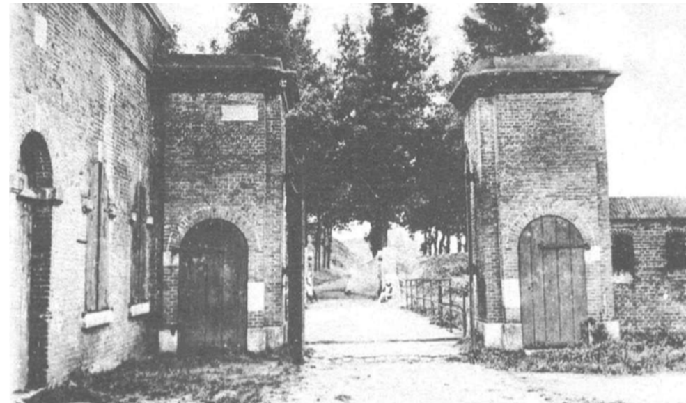
afb. 72: Zichemse poort met wachtlokaal links en brug erachter. Bron: Citadel van Diest: militair bouwwerk doorgelicht: verleden-heden-toekomst. p. 68
