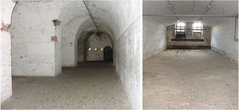
afb. 220: Vloeren in originele kasseien en baksteen- periode periode 1859 - 1894 /. 2018. © ORIGIN
