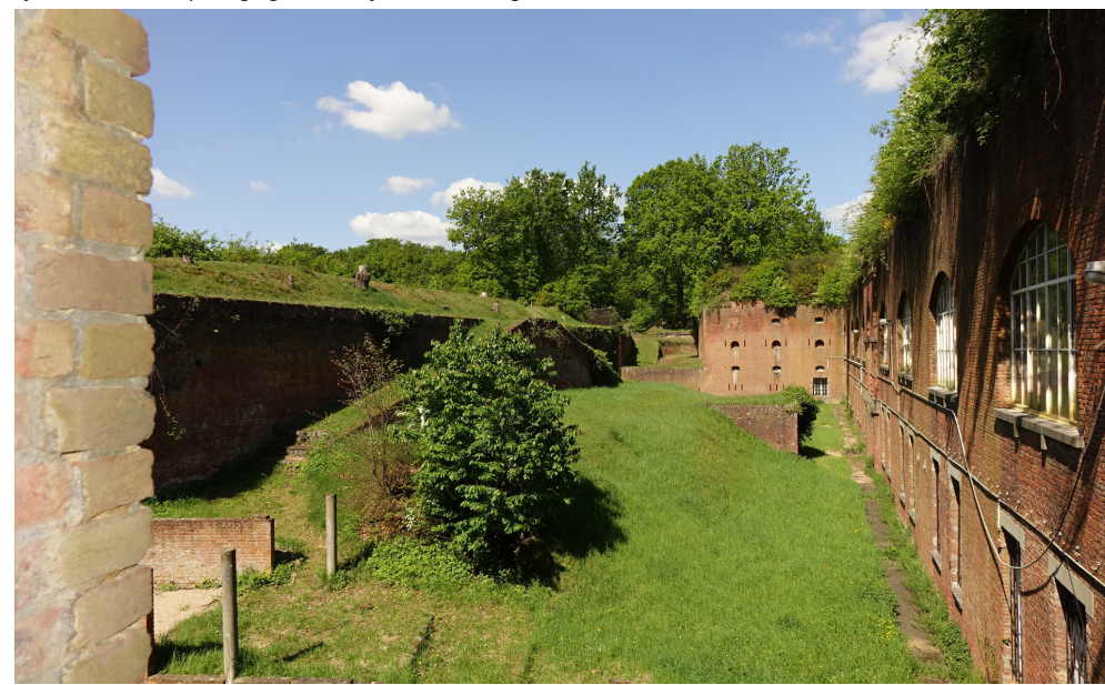
afb. 120: Tenaillegracht voor courtine 3-4 © Origin
