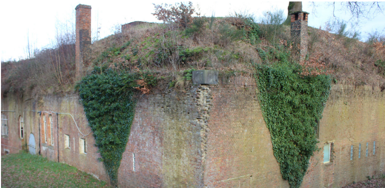
afb. 126: Hoeksteen van bastion in blauwe hardsteen © Origin
