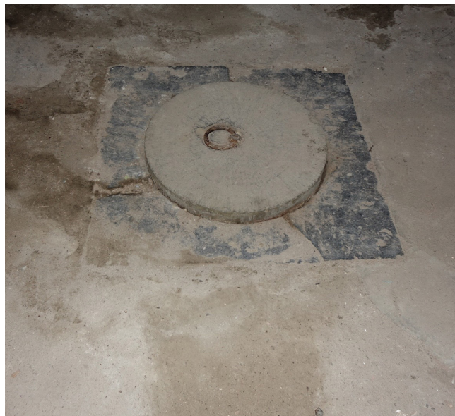
afb. 140: Deksel van een citerne op de kelderverdieping van courtine 3-1 © Origin
