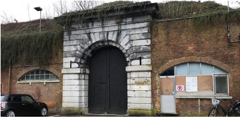
afb. 125: Toepassing van blauwe hardsteen in originele houten toegangspoort © Origin
