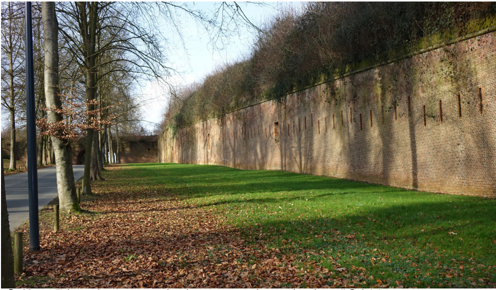
afb. 90: Zicht vandaag op gecreneleerde escarp met achteraan lage batterij © Origin
