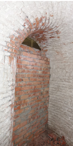
afb. 206: Schietgaten en deuropeningen van de defensieve galerije toe gemaakt met metselwerk. 2018. © ORIGIN
