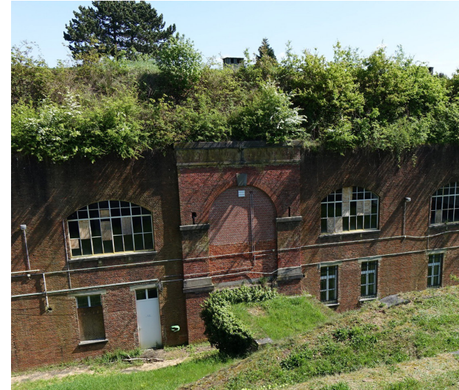
afb. 26: Poterne, ramen zijn verdwenen. 2018. © ORIGIN
