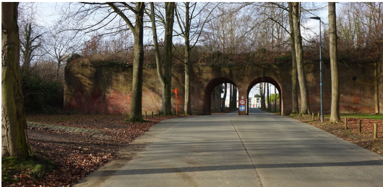
afb. 32: Toegangs­dreef waarvoor 2 travees van lage batterij werden doorbroken. 2018 © Origin
