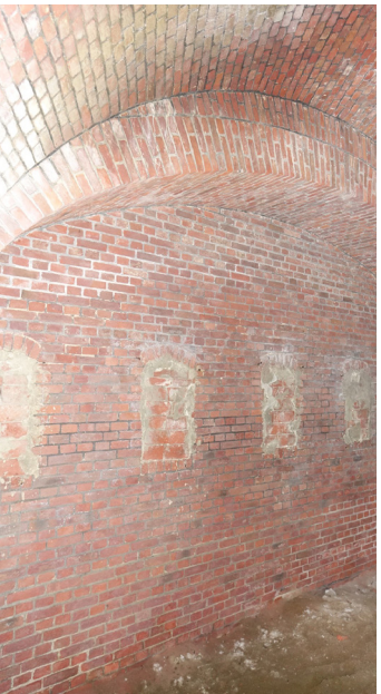
afb. 206: Schietgaten en deuropeningen van de defensieve galerije toe gemaakt met metselwerk. 2018. © ORIGIN
