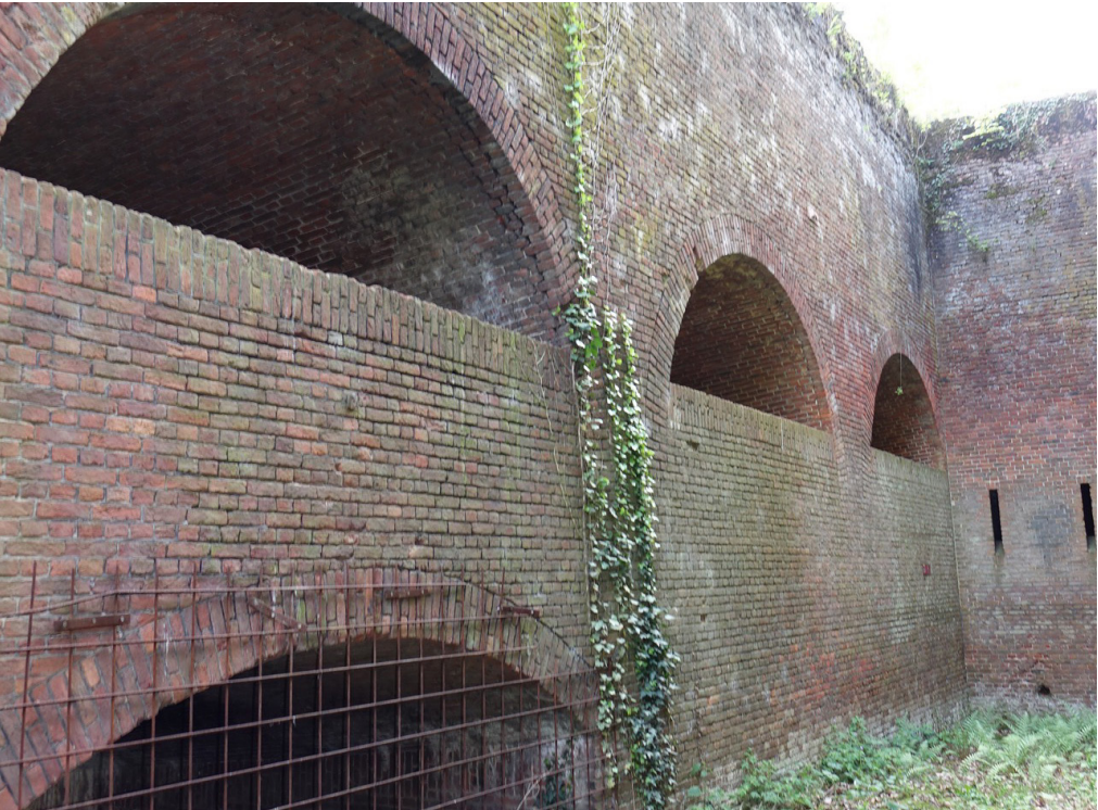
afb. 68: Zicht op openingen, foto genomen vanuit tenaillegracht/frankgracht © Origin
