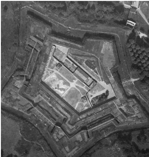
afb. 46: Terreplein volgebouwd. 1926 Bron: Citadel van Diest: militair bouwwerk doorgezicht. p. 83
