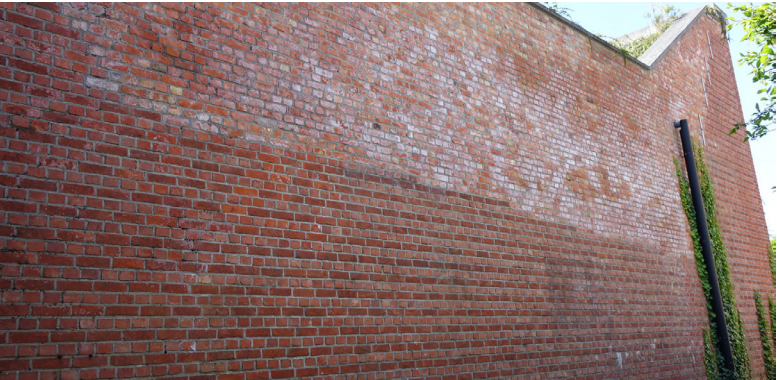
afb. 169: Zouten op de zijgevel van courtine 1-2 © Origin
