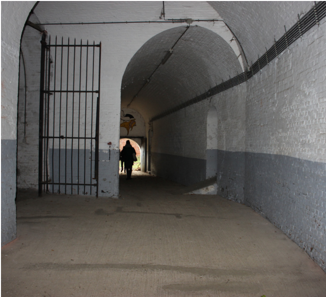
afb. 143: Betonvloer in poterne ©Origin
