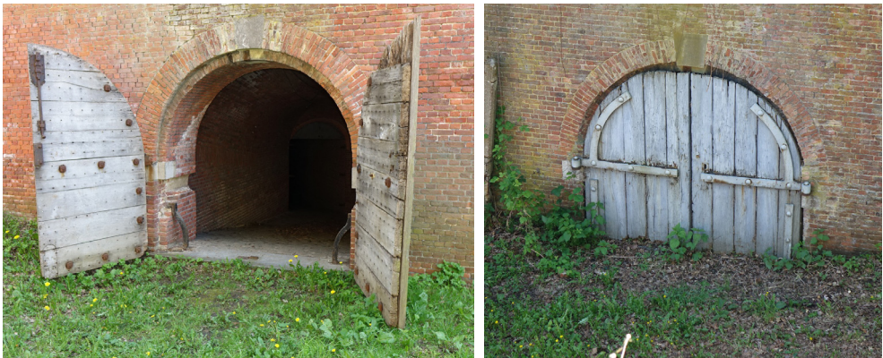
afb. 211: Originele massieve poorten - poort naar gallerijen en poort hoekpoterne - 2018. © ORIGIN
