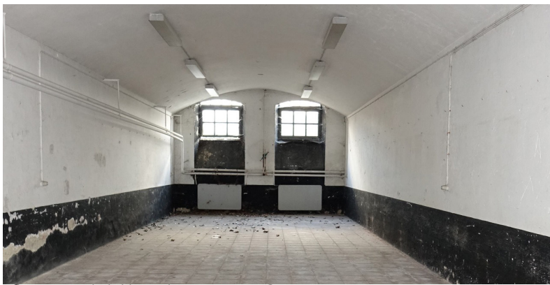
afb. 42: Zicht kelderverdieping courtine © Origin
