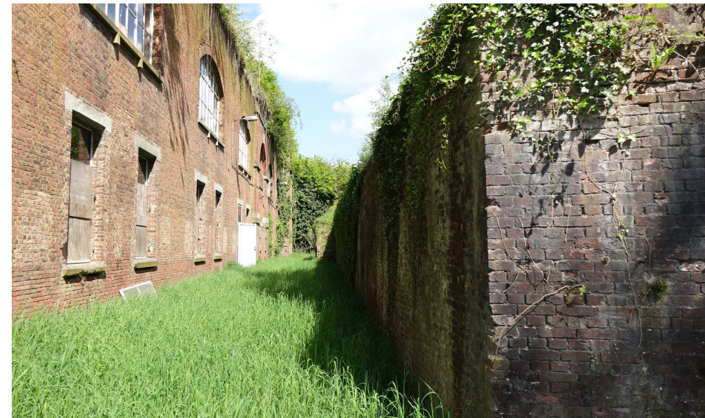
afb. 121: Tenaillegracht voor courtine 4-5 © Origin
