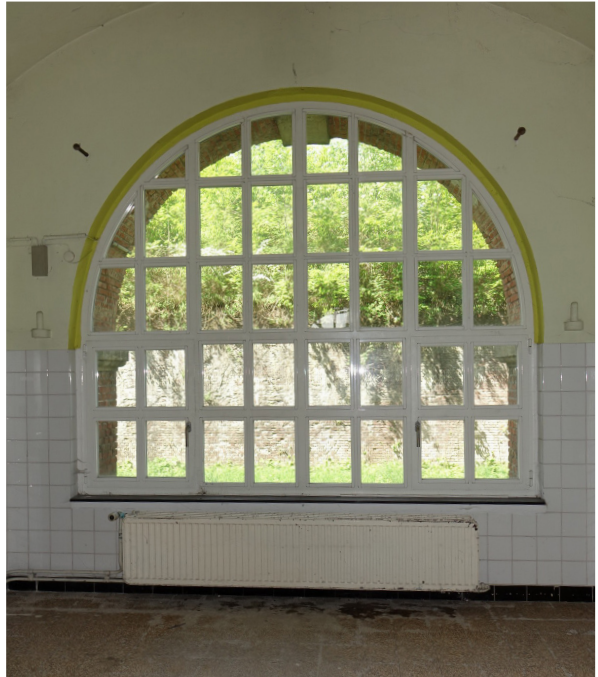
afb. 150: Nieuw geplaatst schrijnwerk in pvc. Hengsels originele poort zijn nog zichtbaar ©Origin
