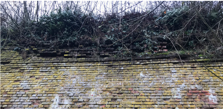
afb. 168: Plantengroei bovenzijde gekazemateerde artillerietoren © Origin
