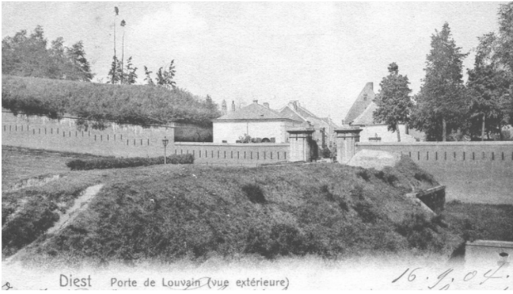
afb. 85: Leuvensepoort met achteraan het wachtklokaal en links de gecreneleerde escarp. 1904. Brn: Citadel te Diest: Bouwhistorisch onderzoek, p. 58
