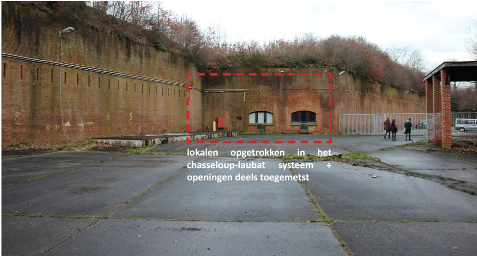
afb. 208: Met metselwerk en lokalen toe gemaakt chasseloup-laubat + gebetonnerde droge gracht. 2018. © ORIGIN
