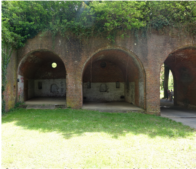
afb. 95: Travees van de lage batterij gezien vanaf de zijde van de citadel (haxo-kazemat) © Origin
