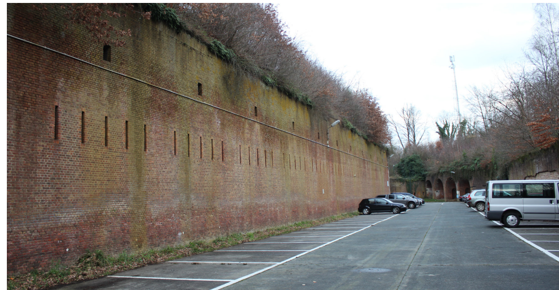
afb. 116: Gebetonneerde droge gracht thv front 2-3 © Origin
