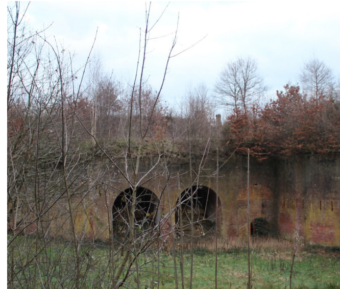
afb. 28: Chasseloup-Labatsysteem, verschillende openingen werden toegemetsd. 2018 © ORIGIN
