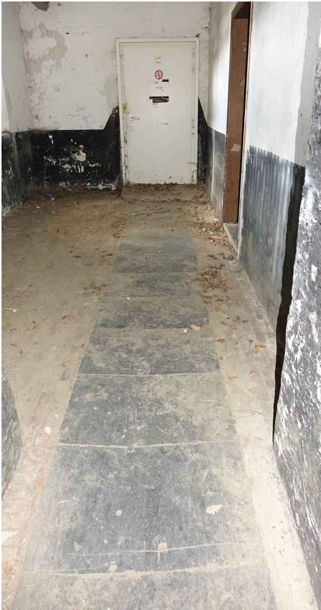
afb. 139: Aquaduct op de kelderverdieping courtine 3-4 ©Origin
