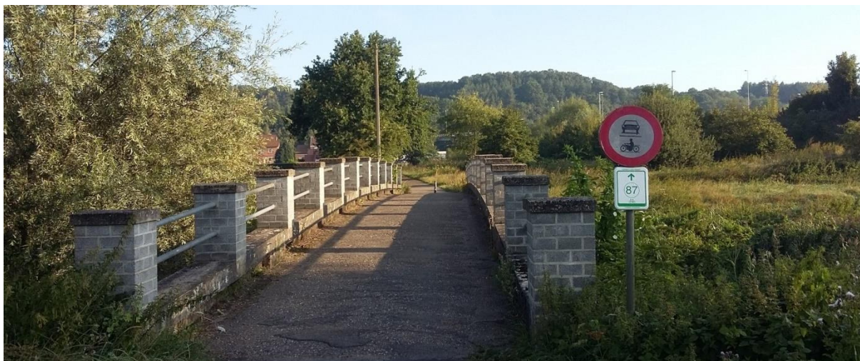
Schaluinstraat ter hoogte van brugje over de Demer
