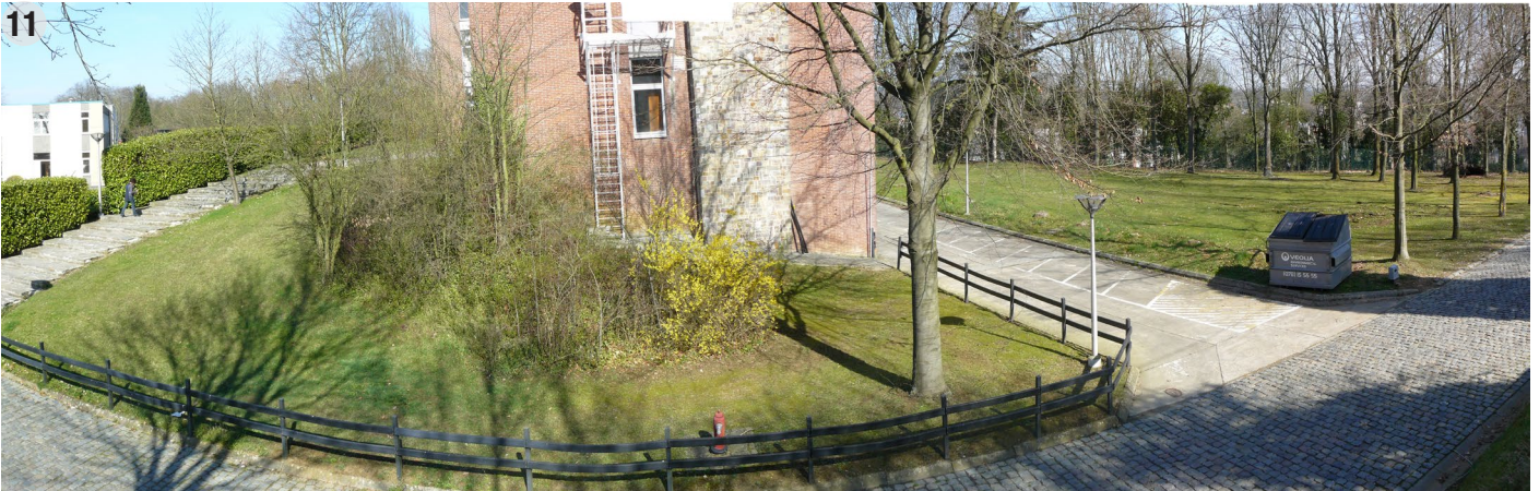
Verstoord talud bij officiersgebouw
