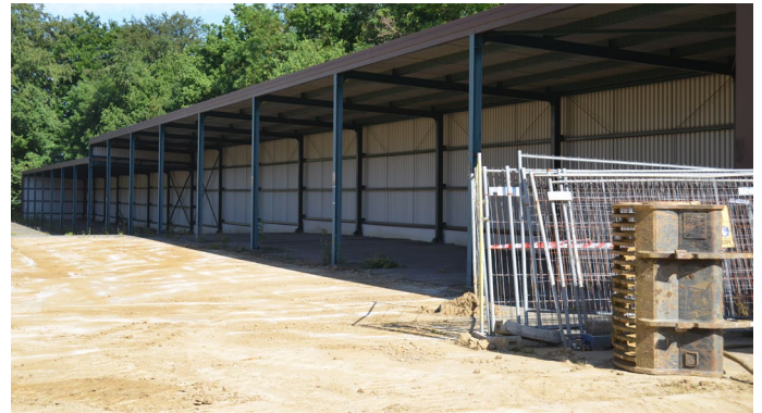
Af te breken bestaande loods die op de locatie staat waar vroeger de bedekte weg was.
