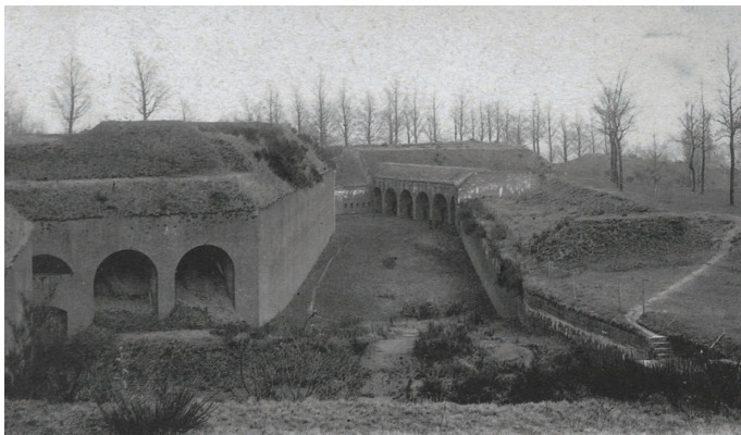
Chasseloup-Labatsysteem met caponnière, droegegracht, lage batterij en bedekte weg prentkaart - privé collectie Daniel Jannes
