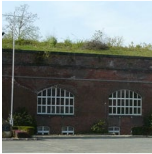
Raampartijen (bestaande toestand)
