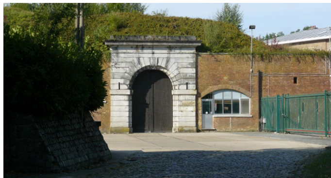
Volledig gebetonneerde droge gracht aan de toegangspoort.
