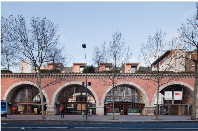
Viaduc des arts, Paris, archief MOP
