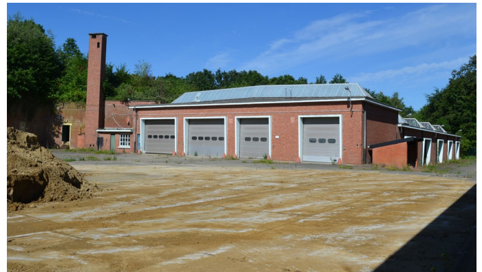
Af te breken bestaand gebouw dat tegen de courtines aan staat.
