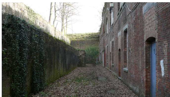
Bestaande toestand tenaille (foto MOP)
