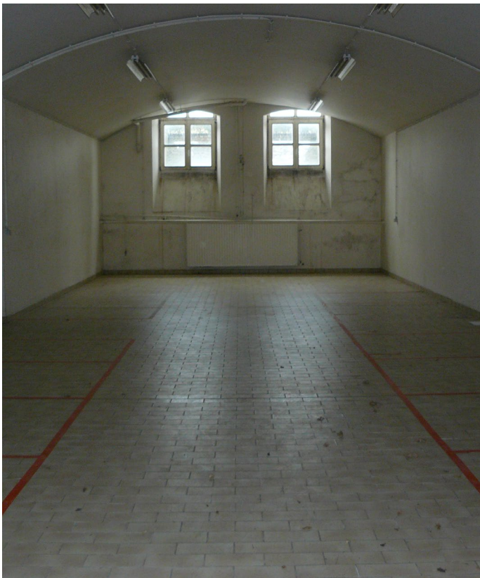
Bestaande toestand courtines (foto's MOP)
