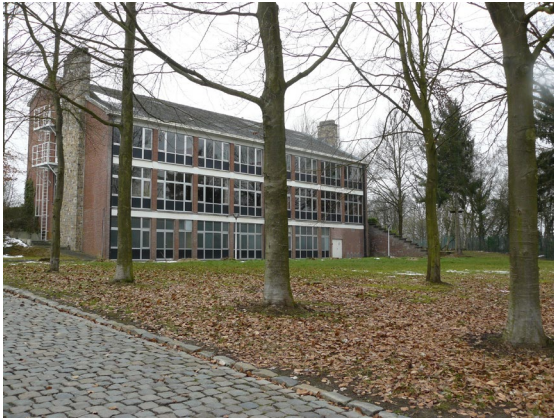
Bestaande architectuur officiersgebouw - hoogte ongeveer 10m
